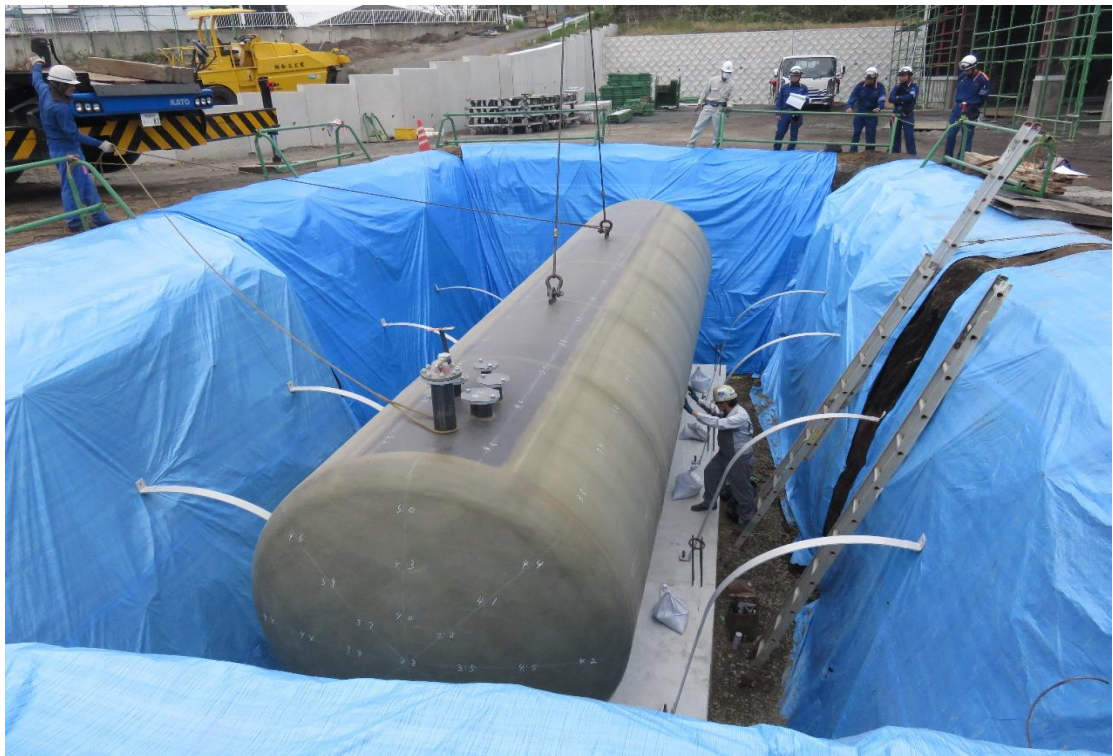
新設危険物施設 検査状況
