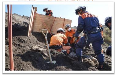
土留め板設定とは、コンパネ 2枚を横にして要救助者の上部 に設定し、採掘した際にかかる 土圧の保持や採掘部に周囲から 流入する土砂を留める方法です。
